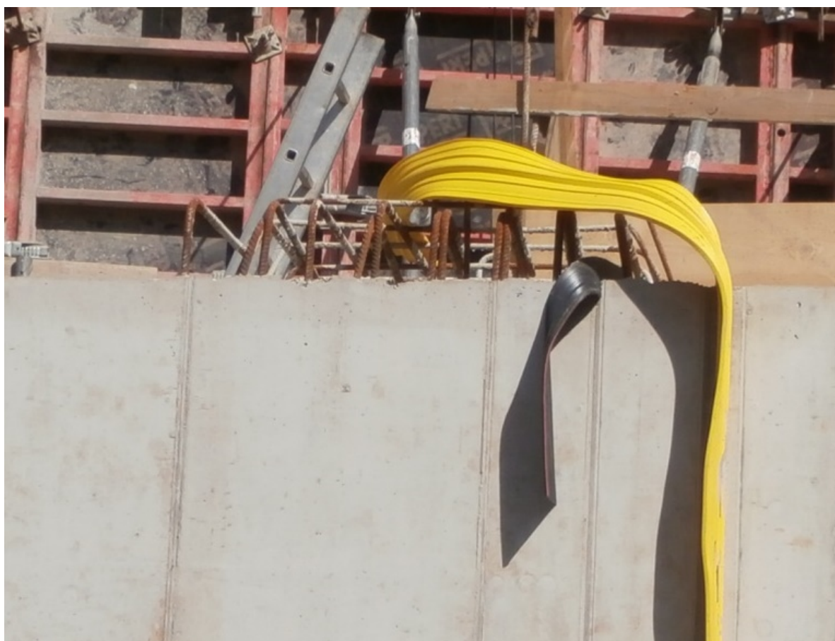
Obr. 5. Chybné uložení těsnicího pásu PS v místě křížení se spojovacím táhlem bednění. Zabetonovávaná část pásu má být vyrovnaná a volná část pásu (nad úrovní PS) dočasně ohnutá.
