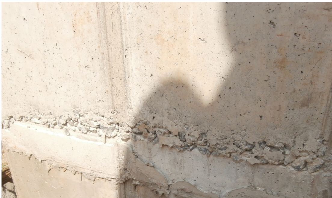
Obr. 10. Chybně provedená ŽB konstrukce - nedostatečné utěsnění bednění v úrovni PS, vyteké cementové mléko, štěrkové hnízdo.
