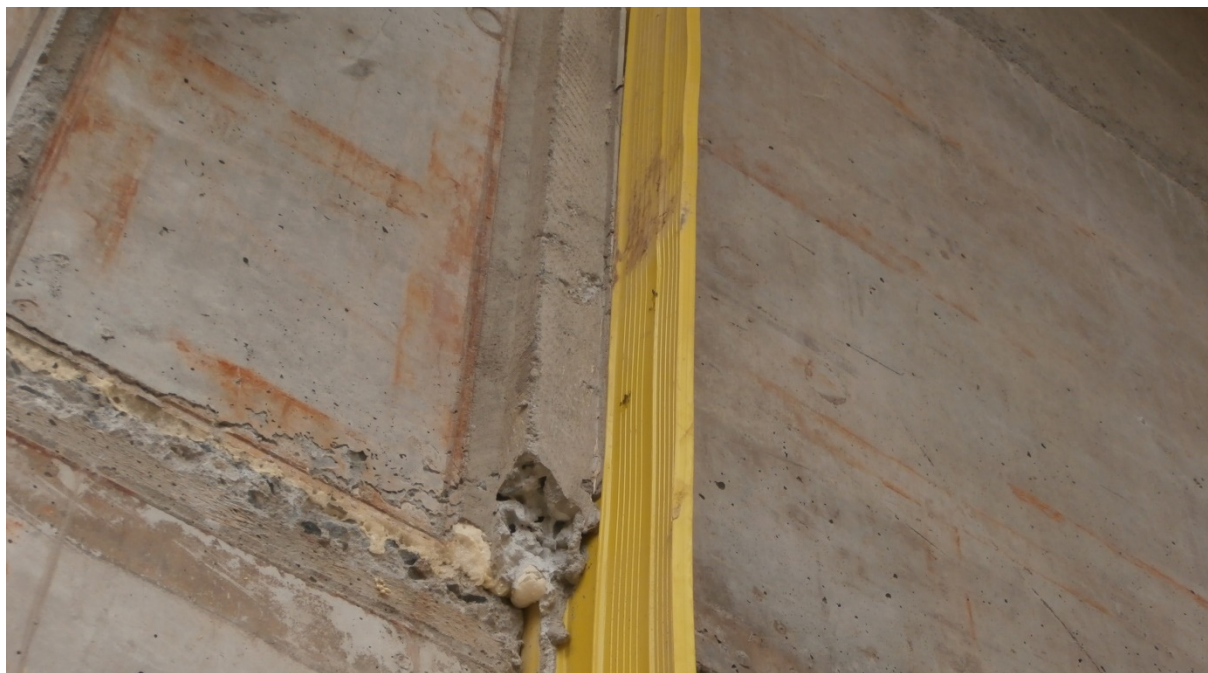
Obr. 3. Chybné provedení bednění v prostoru dilatačního pásu - náletek v místě dilatačního prvku.
