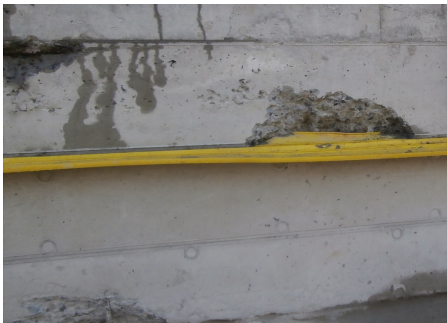
Obr. 1. Chybně uložená výztuž - není splněn požadavek krytí výztuže max. 50 mm.
