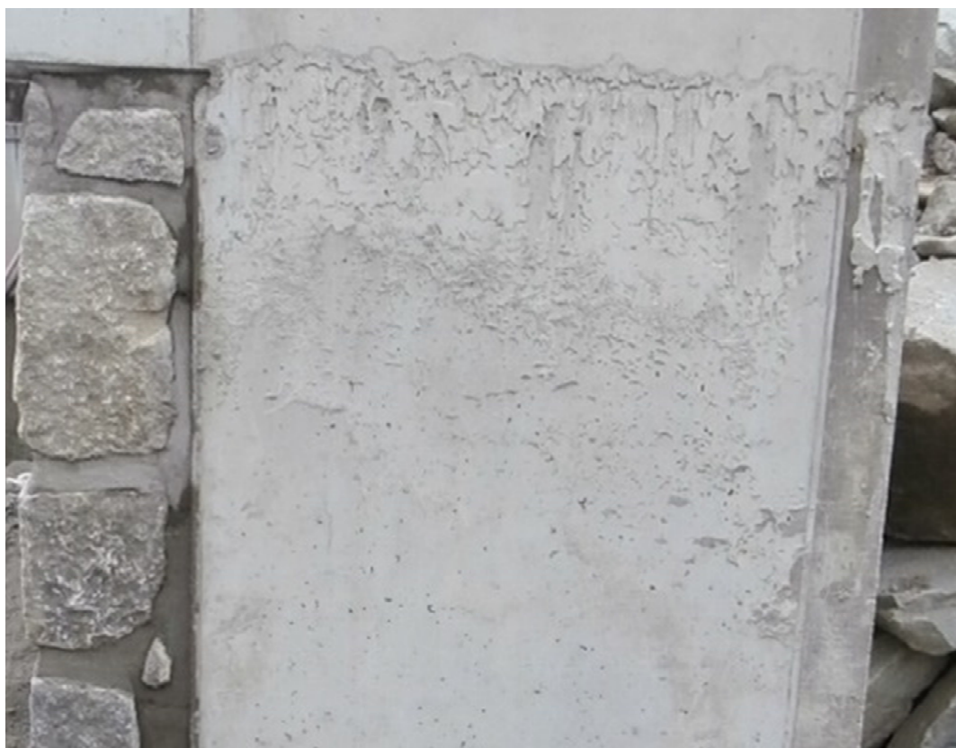
Obr. 14. Chybně provedené kamenné obkladní zdivo - nepřípustná tloušťka betonu mezi rubem kamene a ŽB konstrukcí.
