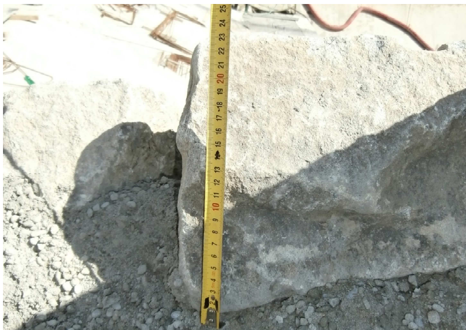
Obr. 9. Kamenná dlažba tl. 0,30 m na sucho - nevyhovující tl. kamene.
