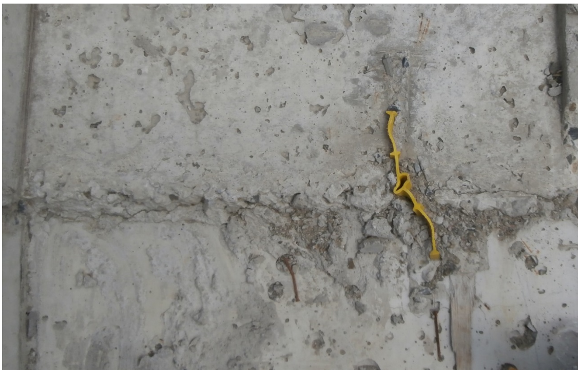
Obr. 8. Chybné provedení DS - deformace těsnicího pásu DS, absence XPS, dilatační prvek pásu není v rovině DS.
