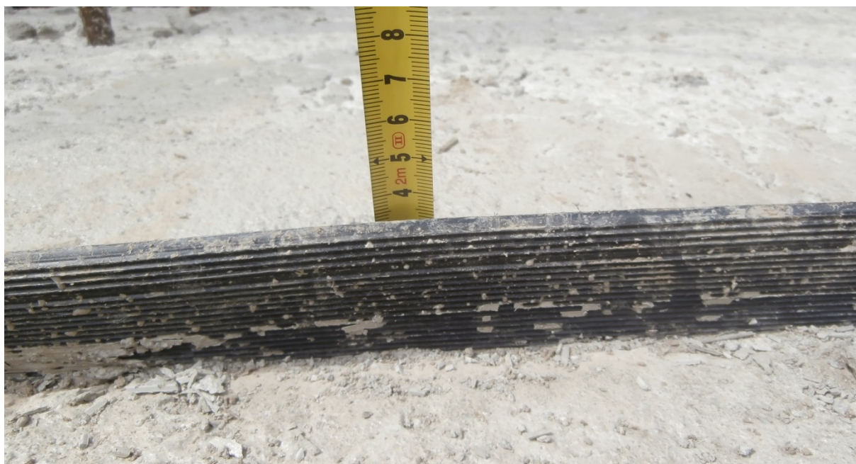
Obr. 3. Chybné provedení bednění v prostoru dilatačního pásu - náletek v místě dilatačního prvku.
