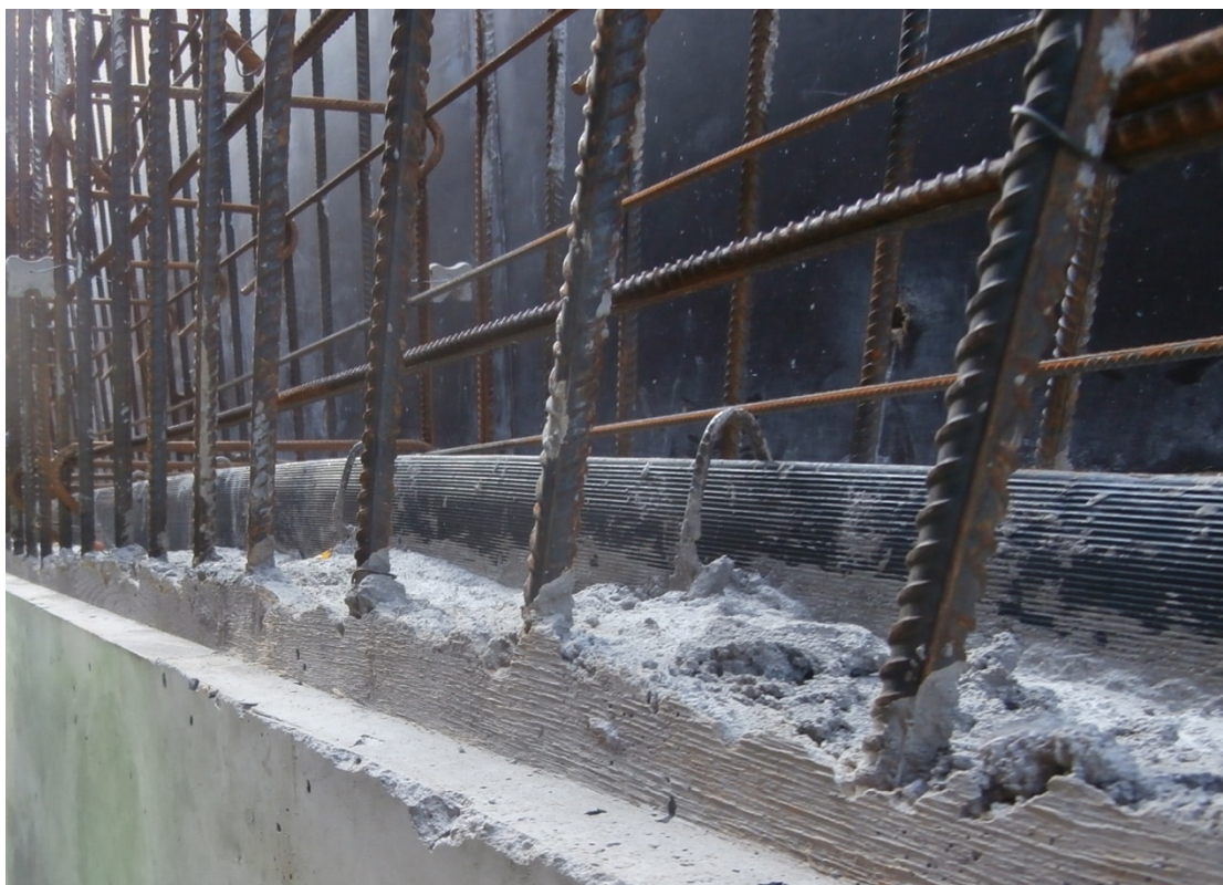
Obr. 7. Chybné provedení PS - povrch spáry není rovinný.
