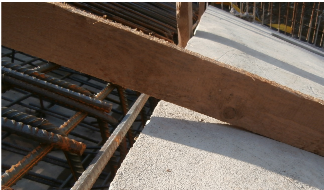
Obr. 11. Chybně provedené ŽB konstrukce - nesplnění požadavku na rovinnost povrchu.
